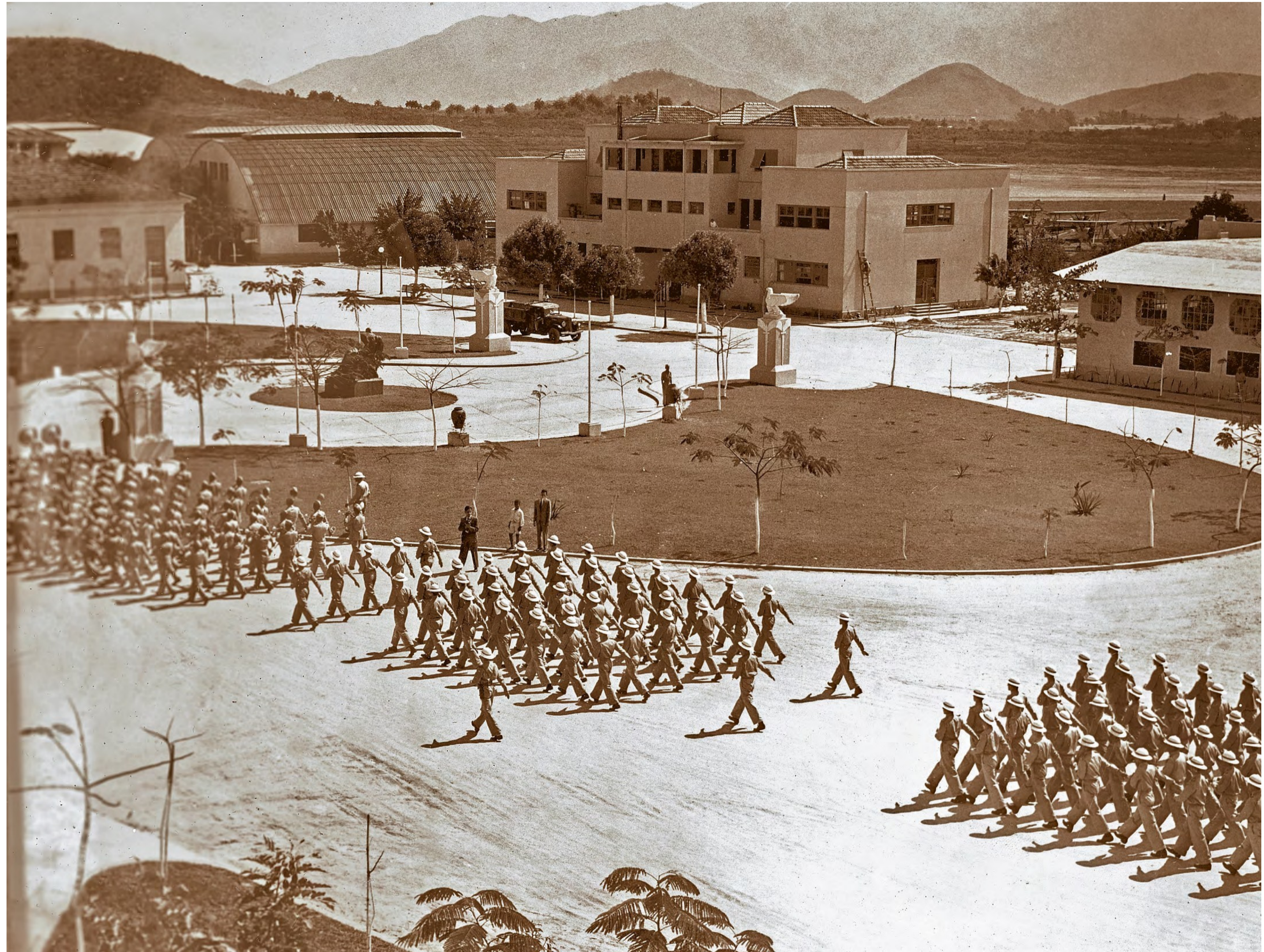
Foto: Vista parcial da atual Praça do Relógio com o monumento ao centro. Detalhe para a ausência do muro da praça. Fonte: MUSAL
