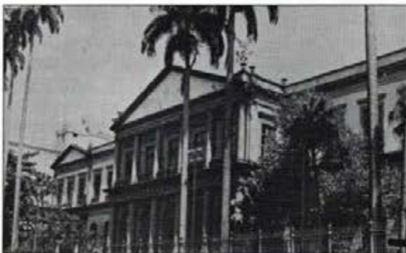
Ocupado até 1983, pela Casa da Moeda, o prédio nº 173 da Praça da República, num dos extremos do Corredor Cultural, se prepara para receber, no futuro, o Arquivo Nacional. O conjunto arquitetônico, tombado em 1938 pelo SPHAN, necessita de obras de restauração.
