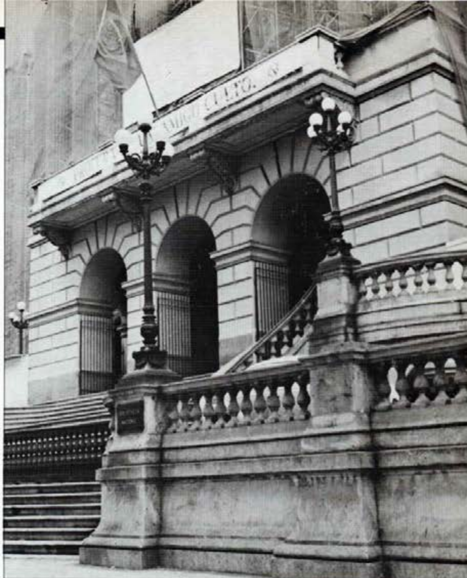
Prédio da Biblioteca Nacional, em obras na fachada
